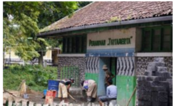
Foto 6. Pembongkaran kolam renang Tirta Merta (Sumber : google. Com)
